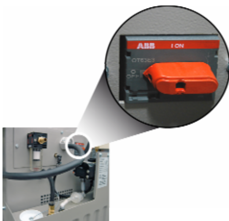
Abb. 2: Hauptschalter an der Rückseite
