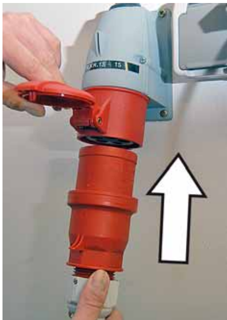
Abb. 27: Spannungsversorgung herstellen
