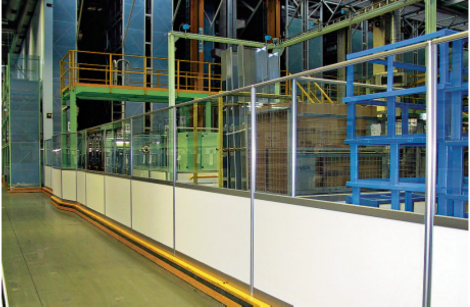
Abb. 78: Abschränkung zum Verkehrsbereich
