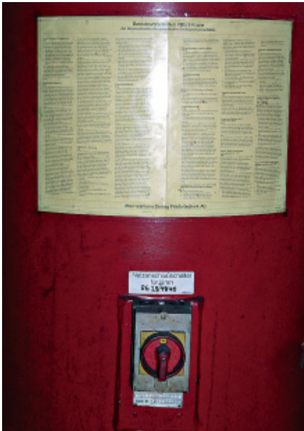
Abb. 52: In der Nähe des Netzanschlusschalters sind die Betriebsvorschriften für den Kranführer jederzeit einsehbar.
