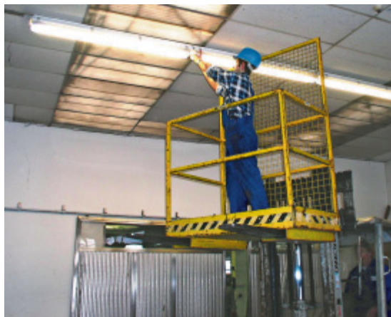
Abb. 45: Hubmast immer in senkrechte Stellung bringen
