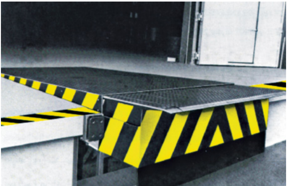
Abb. 76: Sicherung von Quetsch- und Scherstellen. Abdeckbleche sichern die Quetsch- und Scherstellen an den Seiten der Ladebrücke. An der Vorderseite (Hofraumseite) sichert eine Gummischürze gegen den Zugriff zum Gefahrenbereich unter der Ladebrücke. Gefahrenkennzeichnung nach BGV A8
