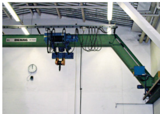
Abb. 56: Der Kran ist an das Hallenende gefahren und der Kranhaken hochgezogen
