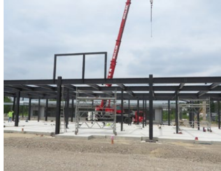
Im Juni 2018 war der Rohbau der Gesamtanlage fertig.
