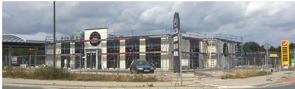
Endspurt: Im September 2018 befanden sich die Außenanlage und die Fassade kurz vor der Fertigstellung.
