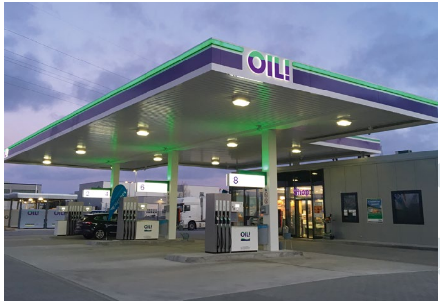
Schritt zwei: Einheitliche Beleuchtung von außen sorgt für Orientierung.
