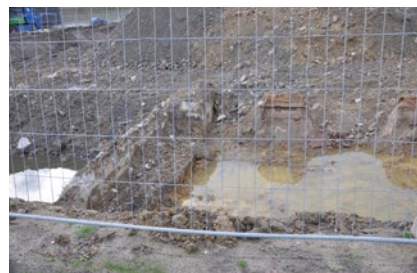
Ähnlich wie auf dem Nachbargrundstück, auf dem aktuell gebaut wird, mussten zuerst die Fundamentreste eines Stahlwerks abgetragen werden.
