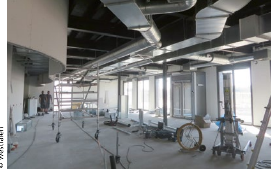
Der Innenausbau und die Gebäudetechnik standen im August 2018 auf dem Zeitplan.
