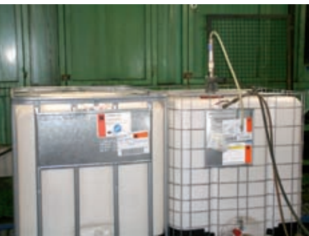
Neben der Reinigung sind neue Dichtungen nötig.
