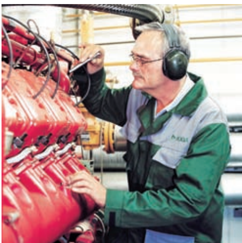
Ein Sachverständiger bei der Anlagenprüfung. An expert at work testing systems.
