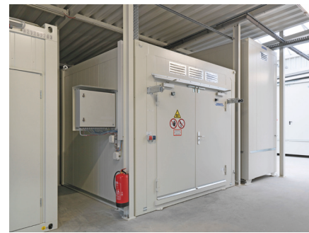
Die einzelnen Komponenten des Lagers sollen nach Abschluss der Umbauarbeiten auf dem Gelände flexibel eingesetzt werden.
