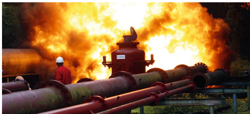
Die neue BetrSichV ordnet auch die Regelungen von Prüfungen zum Explosionsschutz neu.
