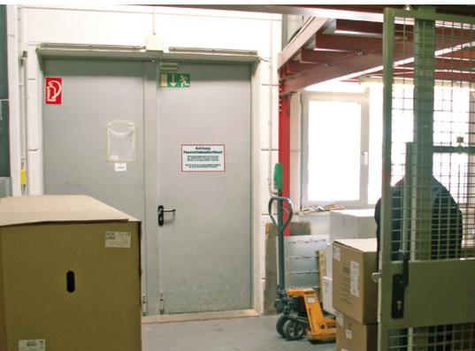
**Regelkonforme Brandschutztüren schließen sich selbstständig. Ein freier Durchtritt muss jedoch jederzeit gewährleistet sein.**
