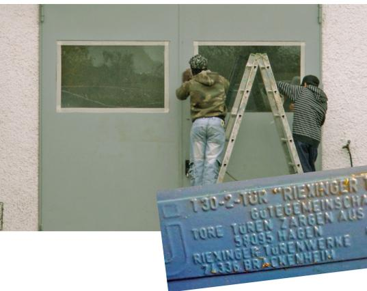
**Bauelemente wie Glas müssen dieselbe Feuerwiderstandsklasse aufweisen wie die Brandschutztür. Auf dem Zulassungsschild müssen Herstellername, Herstellungsjahr, Zulassungsnummer und Typenbezeichnung erkennbar sein.**
