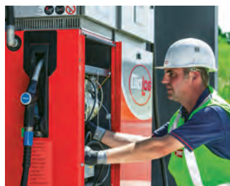
Betriebstankstellen erfordern regelmäßige Überprüfungen
