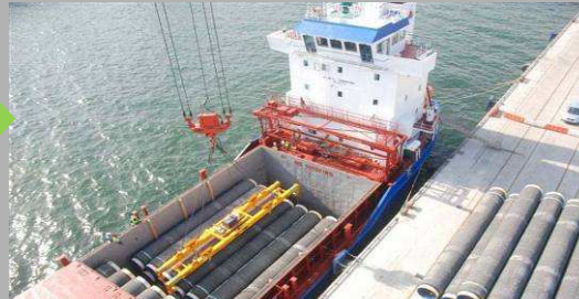
Schiffstransport zu den Rohrlagerplätzen
