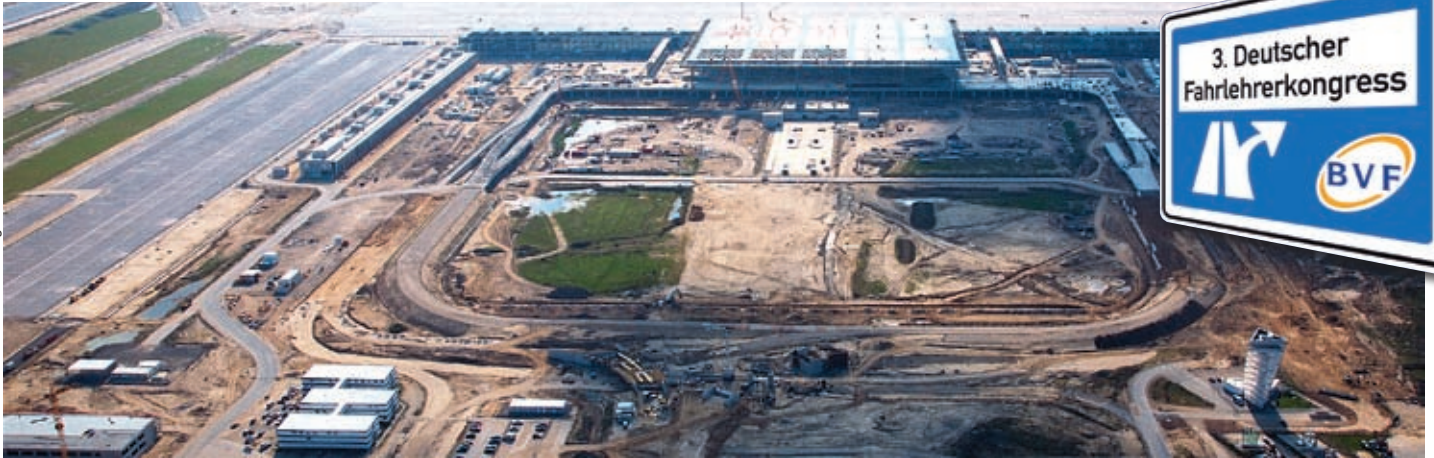
Ein Ziel für Technik-Fans ist eine Rundfahrt über die 2.000 Fußballfelder große Baustelle des neuen Flughafens Berlin-Brandenburg International (BBI) im Süden vor der Stadt. Während der BBI entsteht, läuft der Betrieb auf der Nordseite des Airports normal weiter
