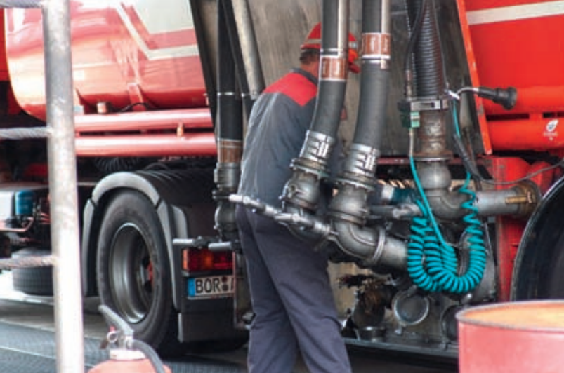
Bei der Füllstation meldet sich der Fahrer an, schließt die Zuleitungen an und erhält automatisch die ihm zugewiesene Menge.
