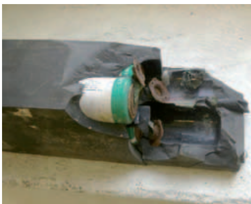
Defekter Block mit primären Lithiumbatterien.
