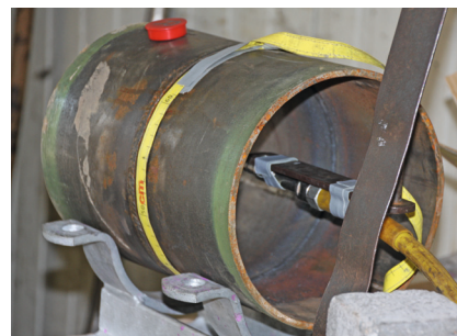
Mit Hilfe der Sonde wird die Schweißnaht geprüft. Auf der Naht außen befindet sich unter dem gelben Maßband der zu belichtende Film.
