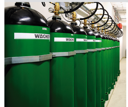
Brandschutz kompakt mit Gaslöschanlage.
