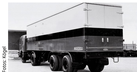
1961: Erster in Europa gebauter Kühltrollanhänger in Vollkunststoffbauweise
