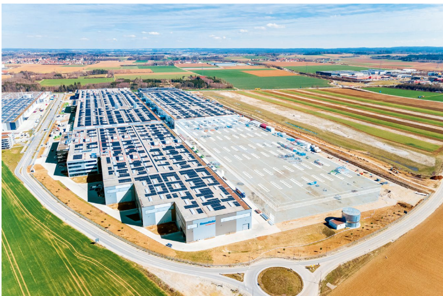
VGP Park München: Nachhaltig durch Photovoltaikanlage und Ausgleichsflächen. Individuell angepasste Lösungen für Forschung, Produktion, Logistik und Verwaltung
