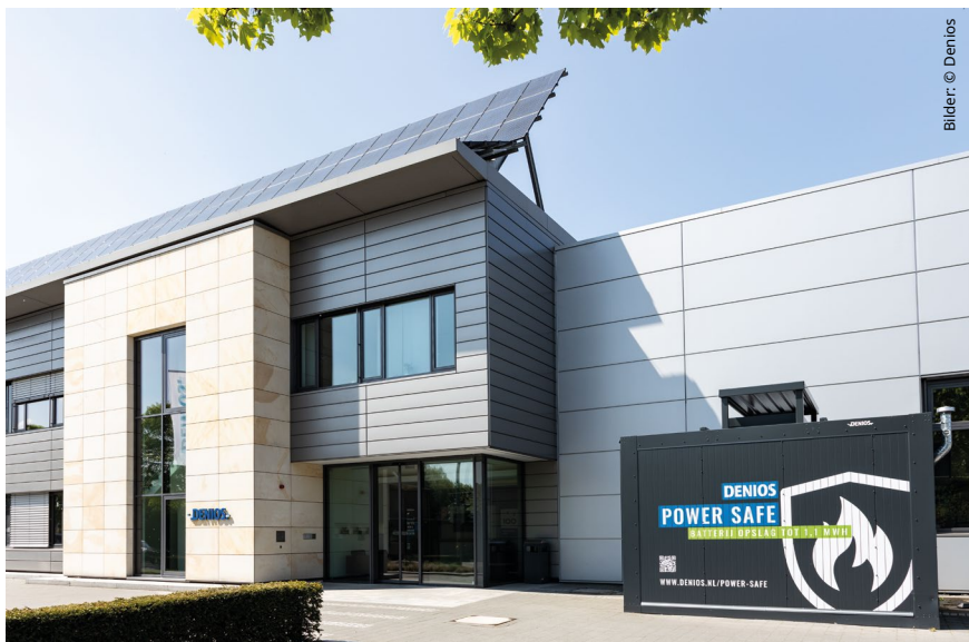
Energiespeicher direkt am Gebäude durch Brandschutz: der POWER SAFE
