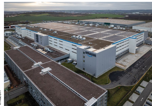
Amazon nutzt in seinem hochautomatisierten Standort Erfurt mehrere Ebenen
