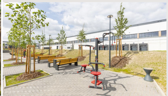
Well-being Bereich im SEGRO Logistics Park Oberhausen
