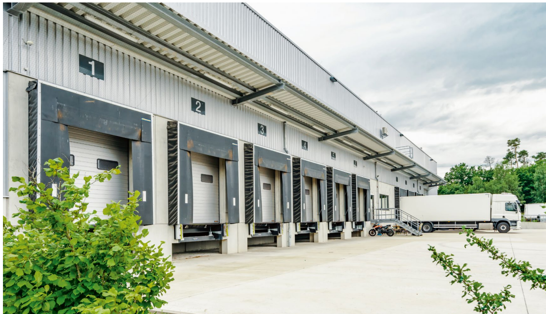
LIP-Logistik-Immobilie Schwabach: verkehrsgünstig gelegen und langfristig rückvermietet
